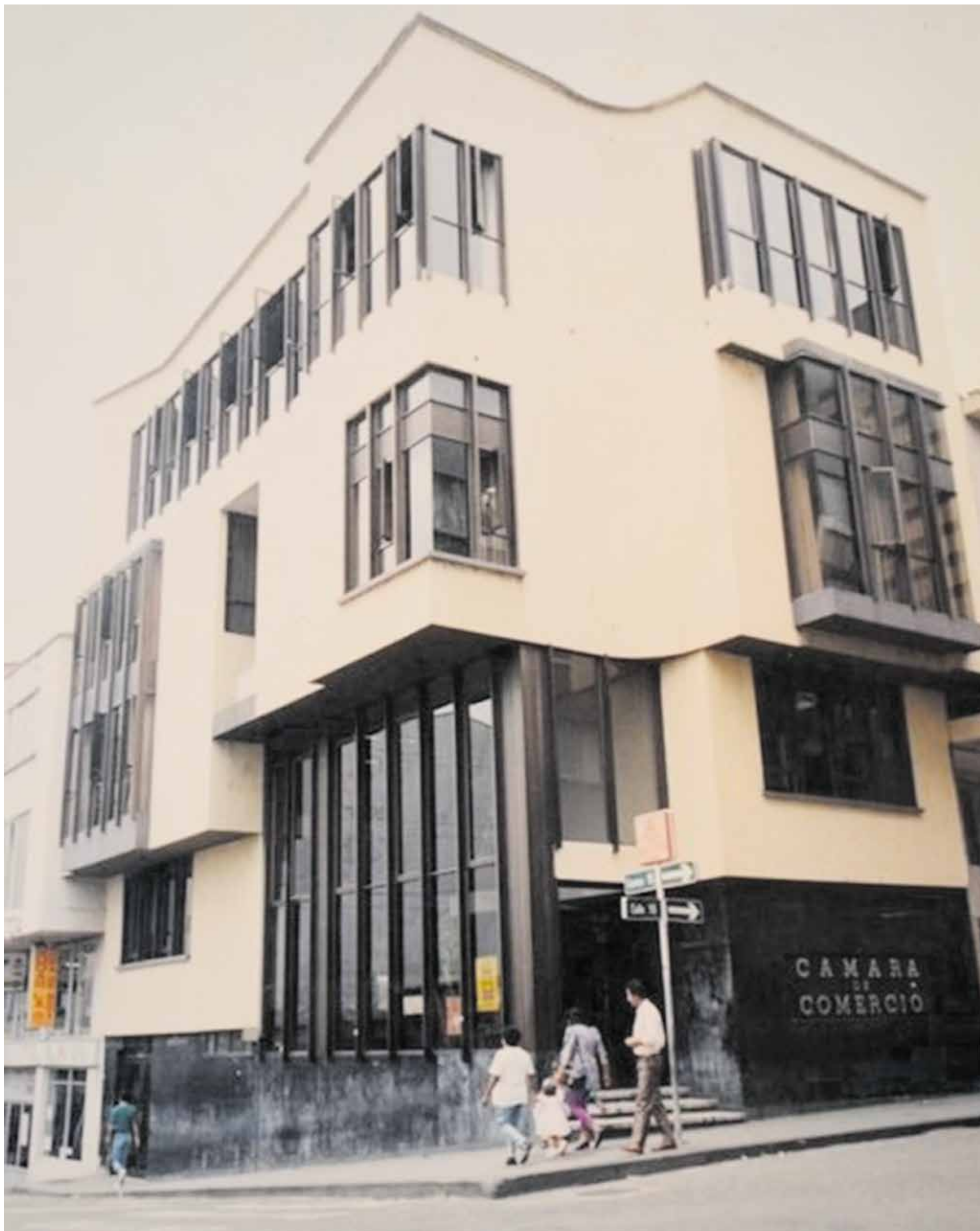
Antigua sede de la Cámara de Comercio de Armenia, edificación propia, calle 19 con carrera 15 de Armenia.
