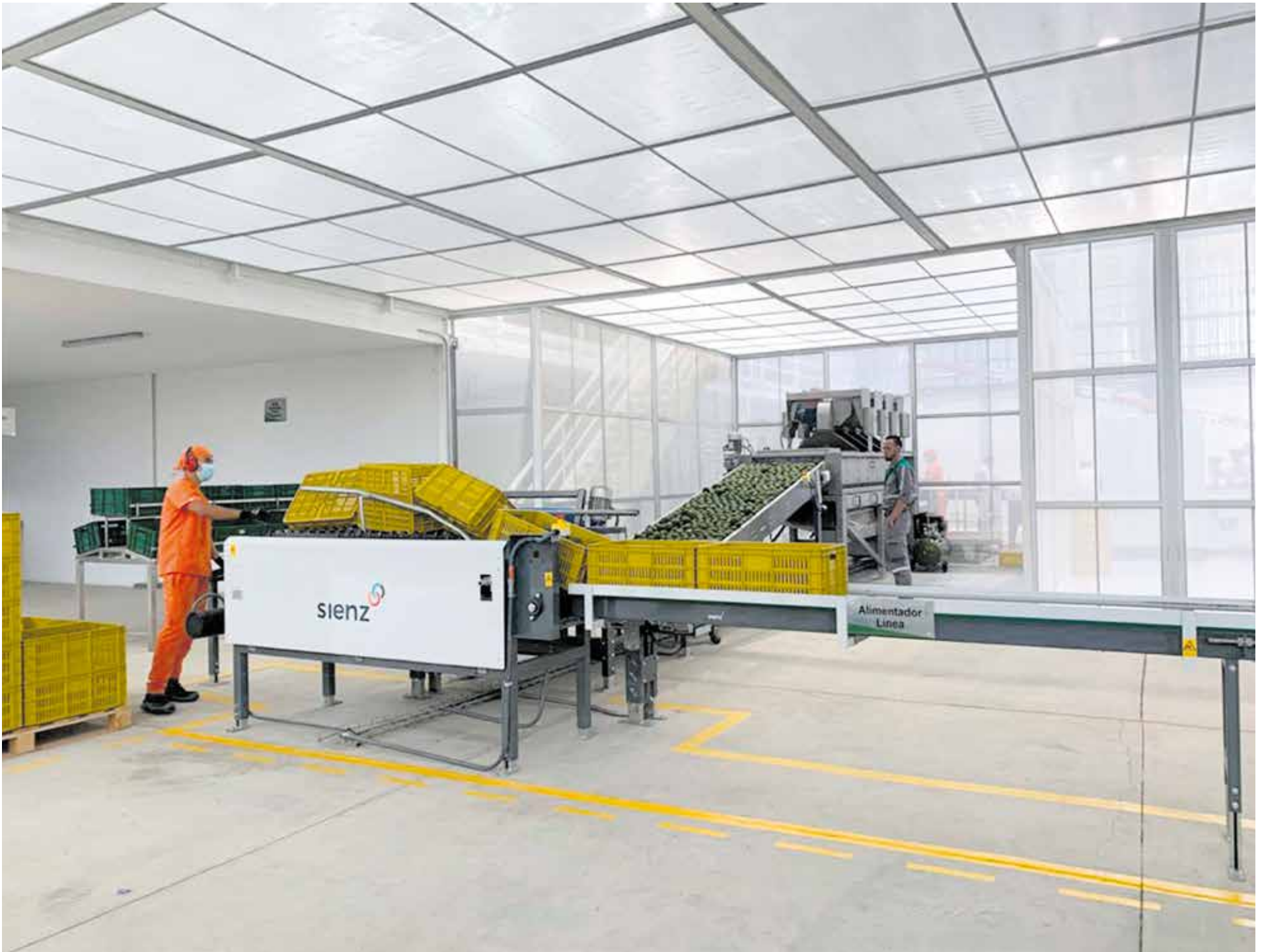
La planta de Green SuperFood está localizada en La Tebaida.
